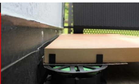
Abbildung 4: VOLFI-ZRV35 mit Wandabstandhalter WAE-K für eine gleichmäßige Fuge im Randbereich
